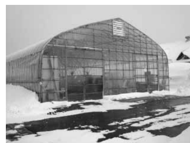
家畜糞尿処理施設 「発酵乾燥ハウス型堆肥舎」
